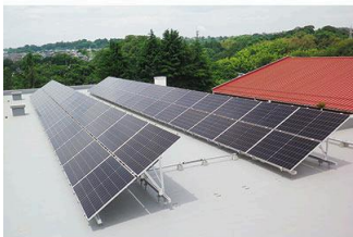
防水一体アンカーを活用した陸屋根に設置された太陽光発電設備
