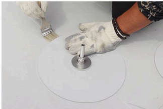
施工時は、アンカーと下地をビスで固定し、円形の防水シートで溶着させる
