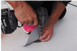
専用の金属アンカーには、ベース材を覆うように円形の防水シートを取り付ける
