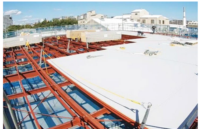
スミルーフ施工2日目
