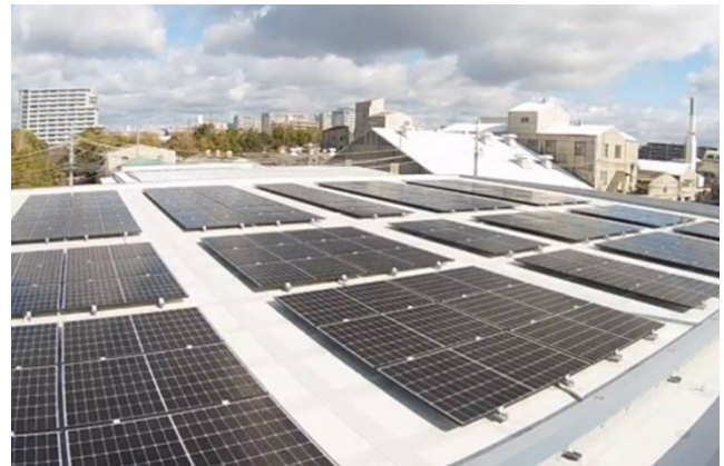
ソーラーパネル施工5日目
