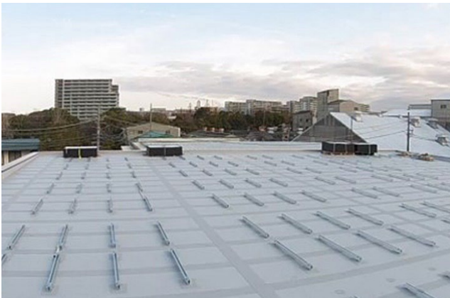
ソーラーパネル施工1日目
